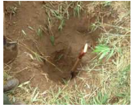
土壌掘削作業中
