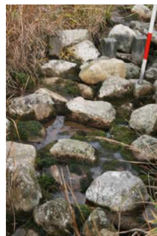
コケの生えた石積みダム
