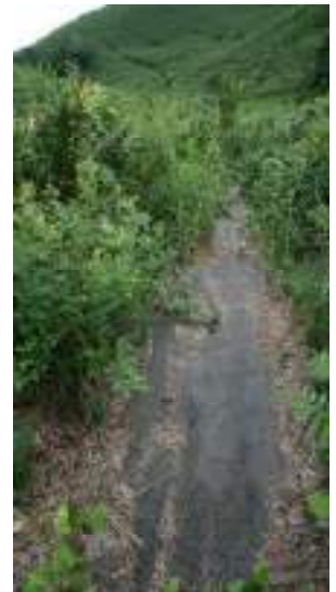
写真30 2010年の人工道 土砂がない…
