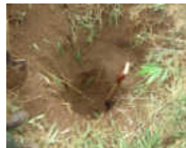
写真47 土壌掘削作業中
