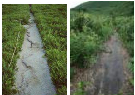
写真67 2000年の人工道 写真68 2010年の人工道 浸食されている 土砂がない…
