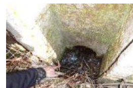
写真81 腐った堰板
